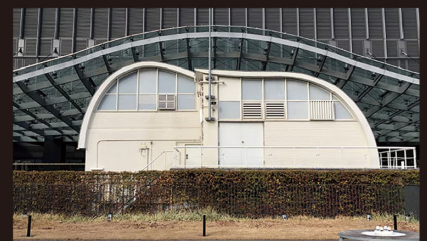
② 屋上塔屋
