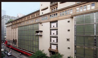
④ 南側の外壁
